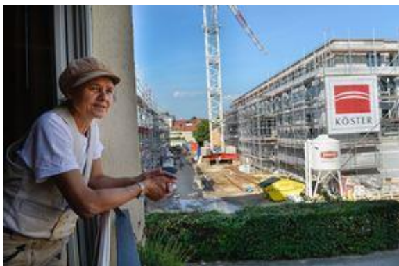
Petra Redert schaut aus ihrem Fenster. Die Sicht ist nicht mehr so, wie sie einmal war. Jetzt schaut sie auf einen massigen Bau und befürchtet zusätzliche Lärmbelastungen, wenn das Gebäude fertig ist. (Karsten Klama)
